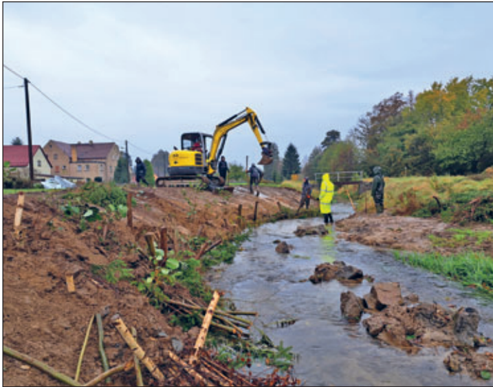
Bereits im nächsten Jahr werden hier die Gehölze austreiben und einen naturnahen Ufersaum bilden. Foto: Wetzelt, LfULG
